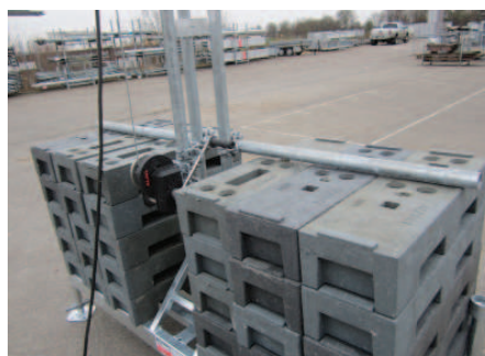
Ballastsicherung mit, (Gerüstrohr 2m und zwei Normalkupplungen)
