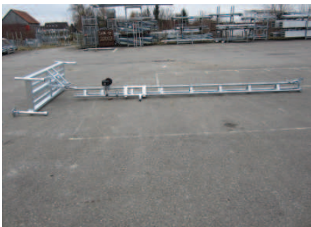
Die Kabelbrücke - Rapid muss in einem sicheren Abstand zum Fahrbe-reich vormontiert werden
