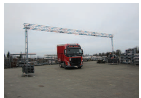
Montierte Kabelbrücke - Rapid
