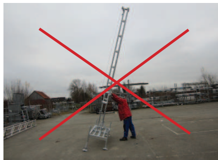
Auf- und Abbau der Kabelbrücke mit mind. 2 Personen
