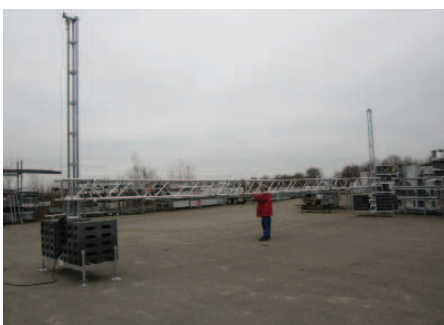
Kabel gegen Herabfallen sichern
